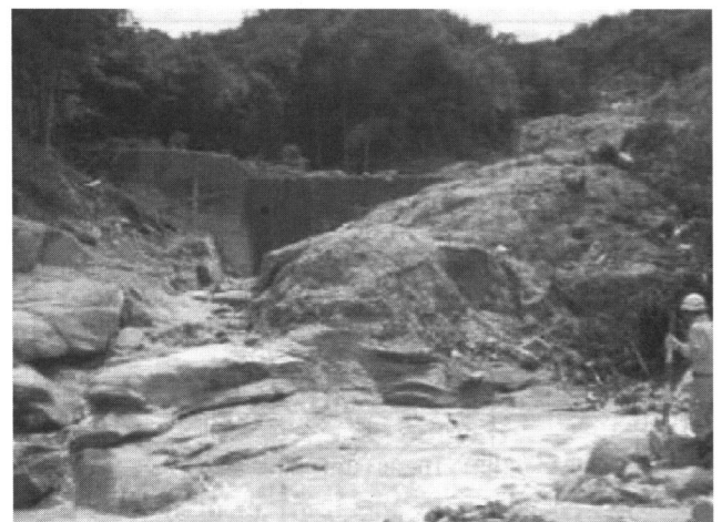
写真4 土石流が一気にオーバーフローした状況
