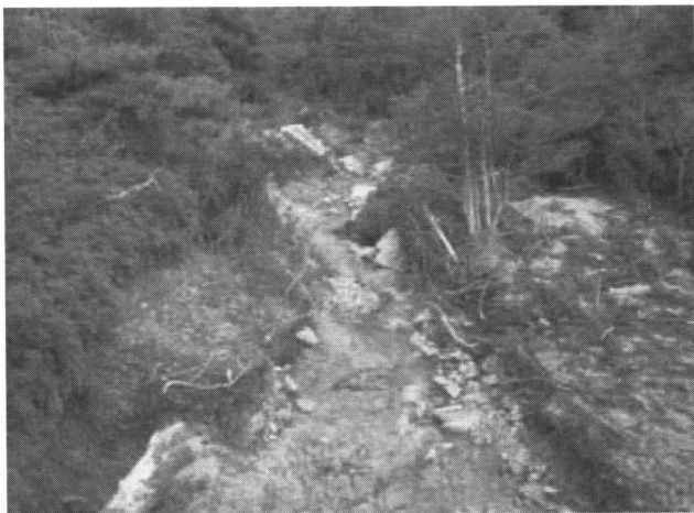
写真10 砂防ダム下流側土石流幅の狭まった状況
