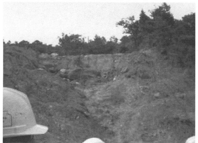
写真8 崩壊源頭部状況
