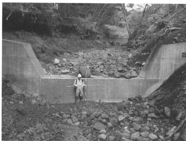
写真2 既設砂防施設調査
