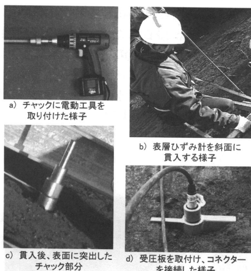
写真3 スクリュー貫入型表層ひずみ計 (SPS) の設置過程
