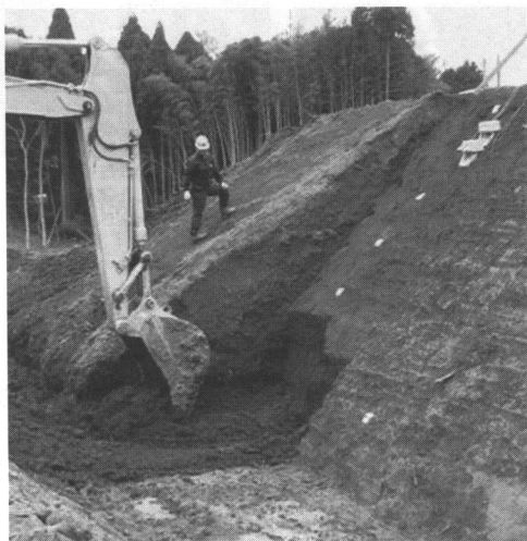
写真4 バックホウを用いた切土の様子
