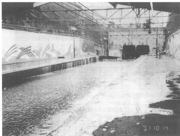
写真1 隆起し土砂が流入した新小平駅 2)
