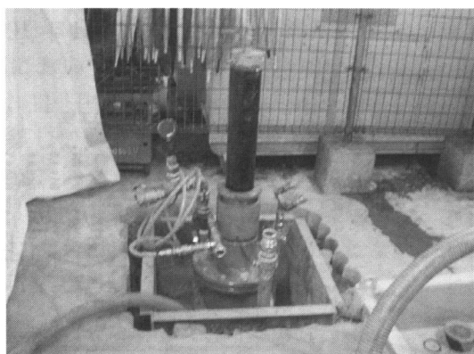
写真2 止水ボックス設置状況 3)
