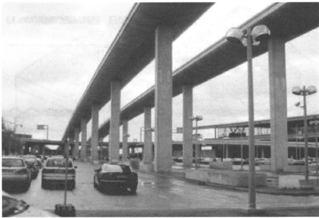
図10 シャルル・ド・ゴール空港のアクセス道路の橋脚 (写真提供：北橋建治)
