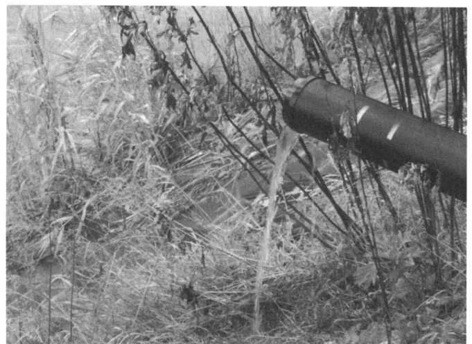
写真-1 集水井からの排水状況 (H 20/10 撮影)
