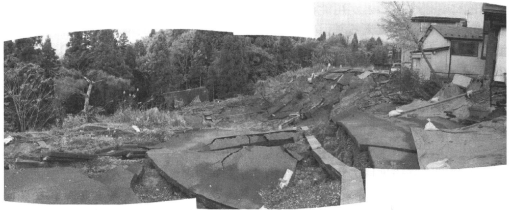
写真1 斜面崩壊 No. 3 の現場写真 [(株)興和・柴田氏撮影]
