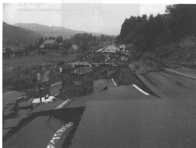
写真1 国道117号 小千谷市細島地内の道路被災状況
