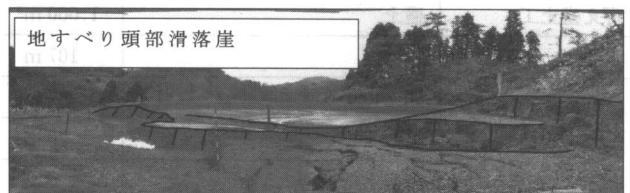
写真4 地震直後の被害状況2
