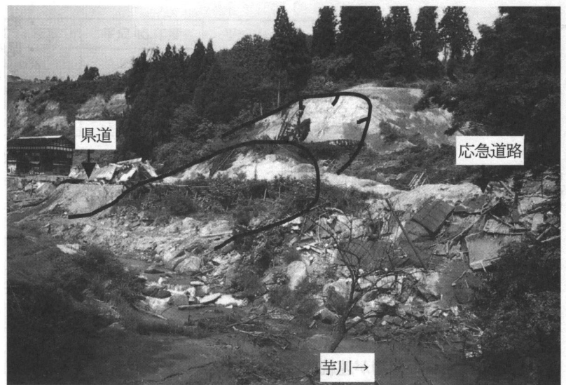
写真2 被災現場全景
