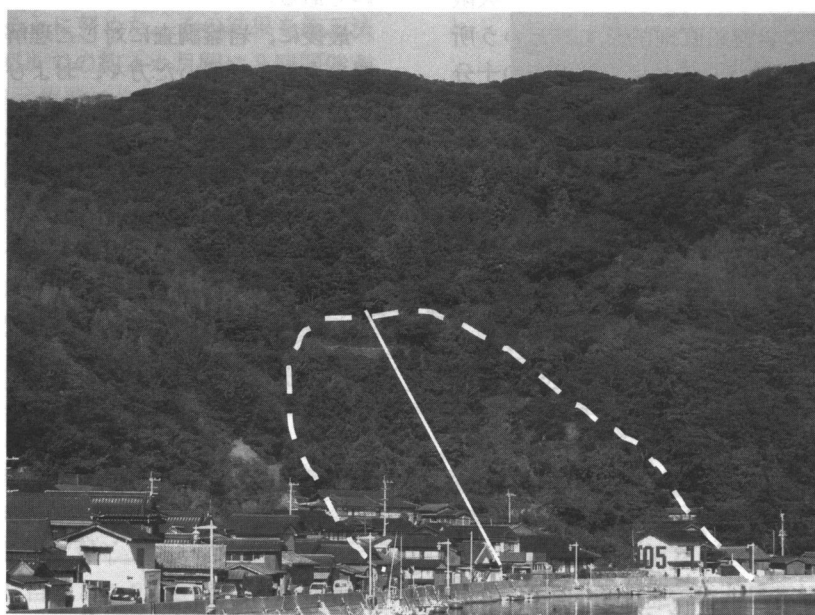
写真1 地すべりブロック（三方を急傾斜地に囲まれた緩傾斜地。地表水が集まりやすい。）
