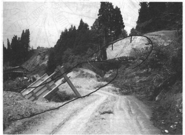
写真1 応急道路の状況
