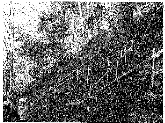
写真4 崩壊箇所のセンサの状況
