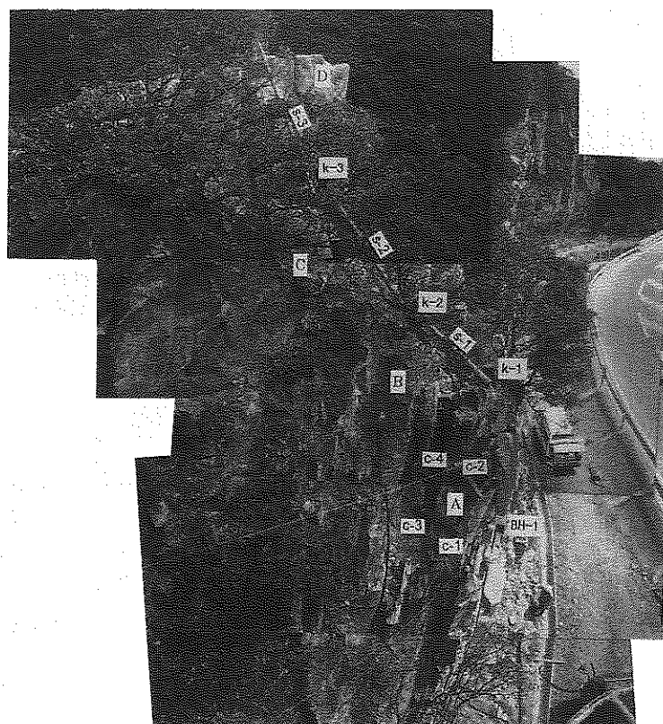
図2 天鳥橋西地区観測計器設置状況
