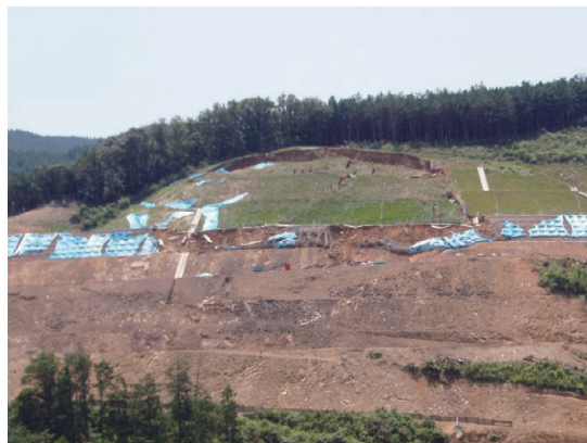
降雨後の比較的大規模な崩壊
