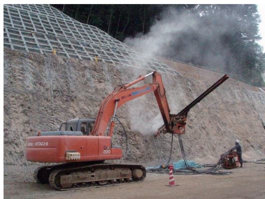
法面でのロックボルトの打設状況
