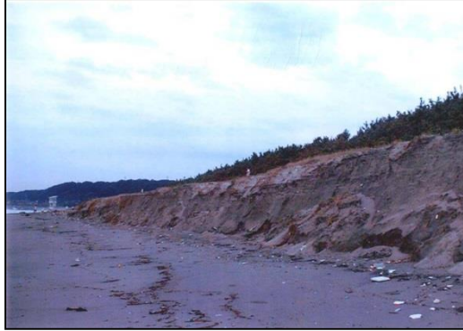
図 3.2.12 海岸浸食の例 静岡県牧之原市相良（新第三紀層の侵食）
