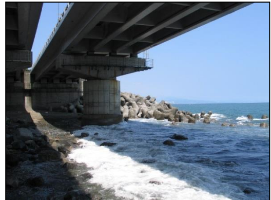
図 3.2.13 東名高速道路 静岡県由比海岸 橋脚基礎をコンクリートで巻き立て、岸壁にはテトラポッドが積まれている。
