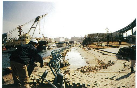
1. ポートアイランド 北側護岸の崩壊
