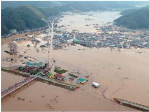
(円山川の平成16年台風23号破堤状況 13) )
