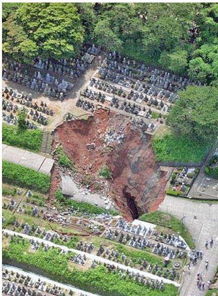
(平成17年8月 福井市・足羽山公園西墓地陥没事故 12) )
