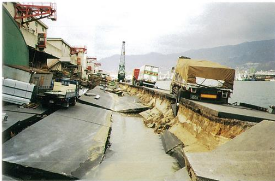
10. 深江浜北側護岸への崩壊
