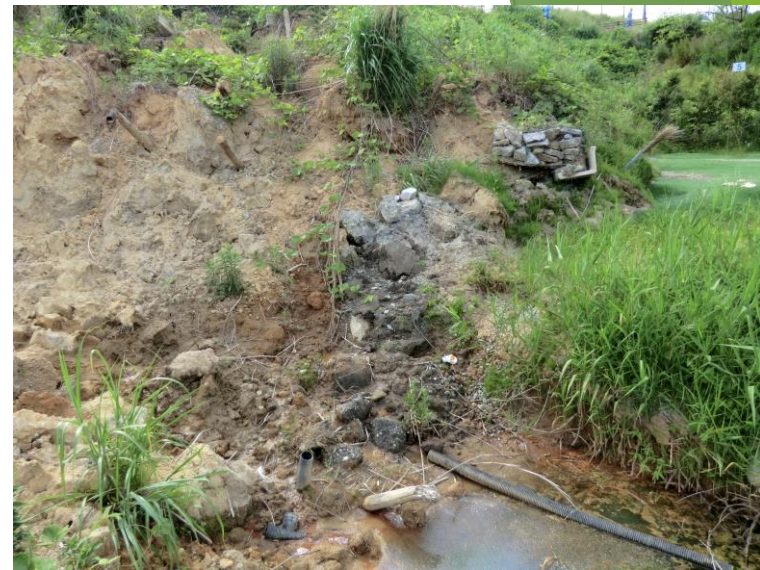
公園と道路盛土との境界にはふとんかごが設置されており、盛土基盤部には排水層が設置されている。道路盛土部は比較的乾燥していたが、ふとんかご位置以深は湿っている。写真中央下の水面は沼地の水面とほぼ同じ。
