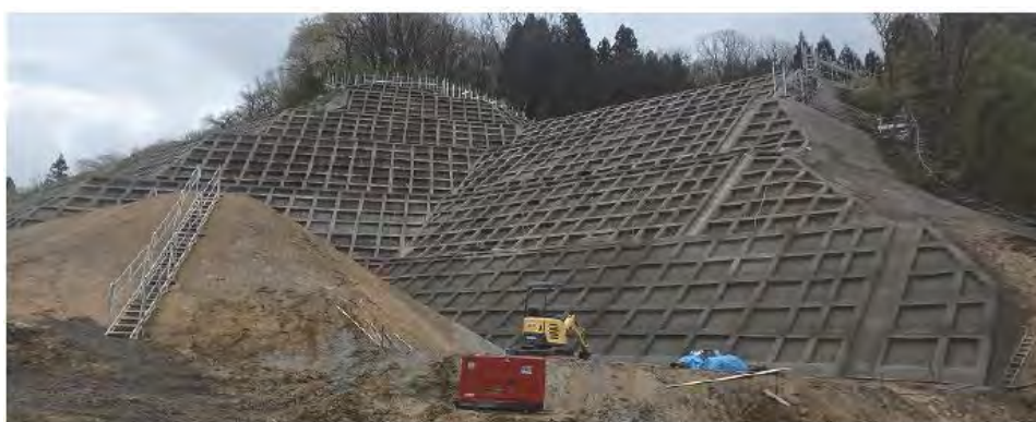
図4 切土施工後の現地状況写真
