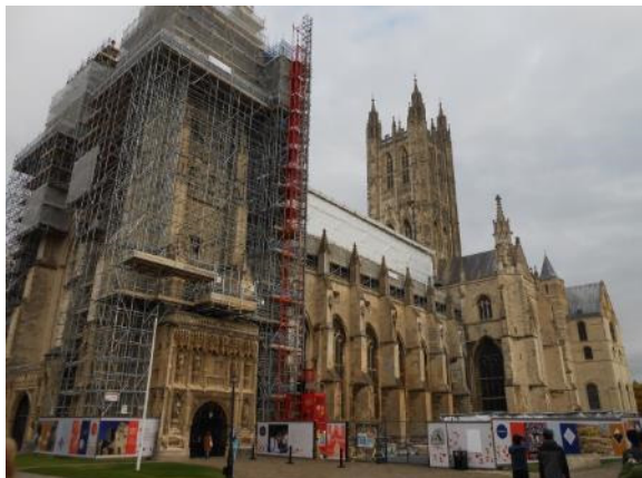
美しい大聖堂に設けられた大規模足場
