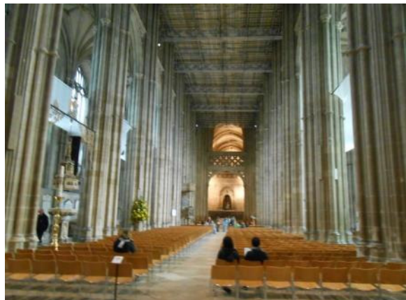
内部空間に違和感を与えない天井足場
