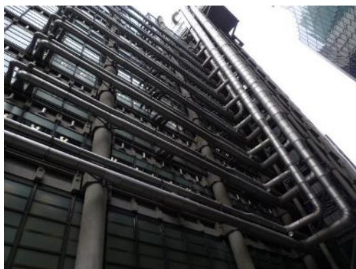
(1) 外壁のパイプ
