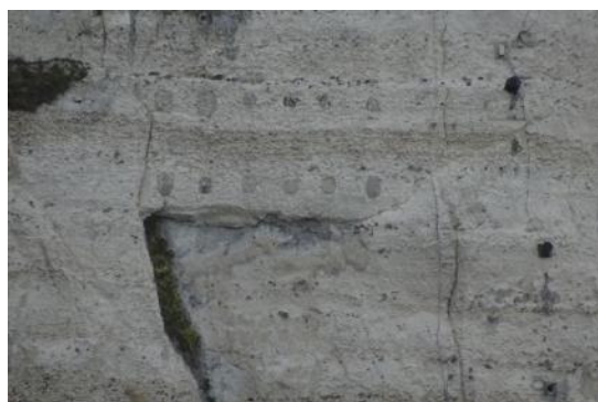
写真左10 住宅背後の崖面に補強の形跡
