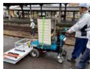
3次元地中レーダによる測定
