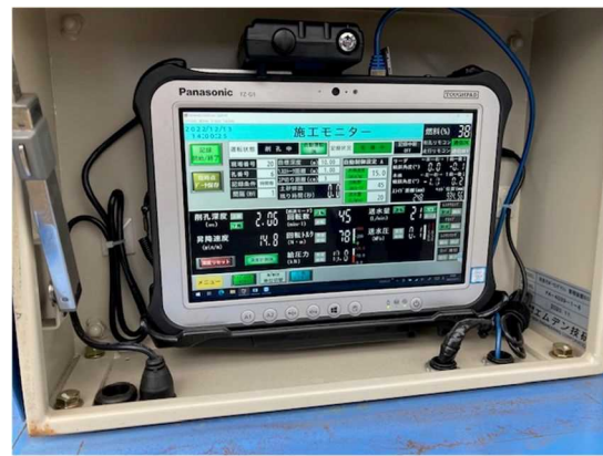
施工モニター
