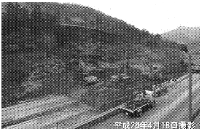
写真 2.5.2 大分自動車道の災害復旧状況
