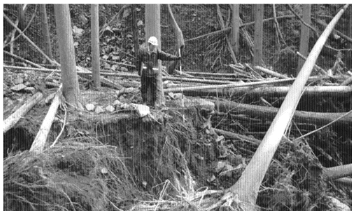
写真 2.6.2 被害状況調査
