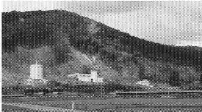
写真 2.8.2 厚真町富里地区 富里浄水場裏の斜面崩壊
