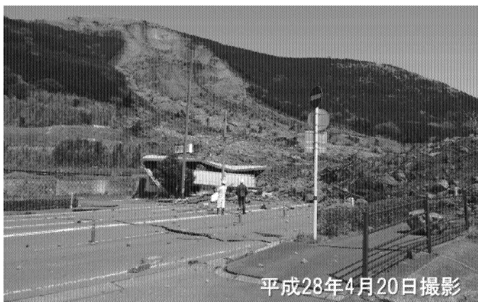
写真 2.5.1 阿蘇大橋付近の大規模斜面崩壊
