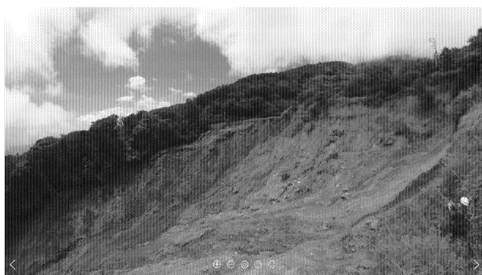
写真 2.12.1 逢初川源頭部崩壊箇所の現地調査
