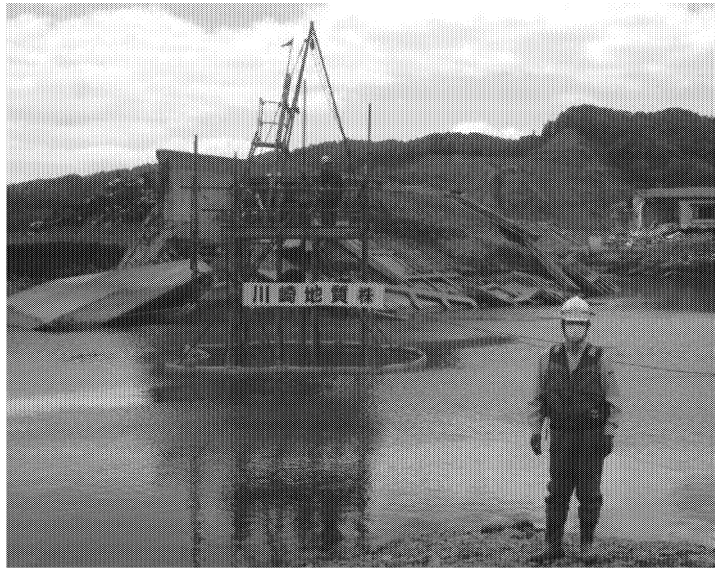
写真 2.1.1 防波堤破堤箇所の地質調査ボーリング
