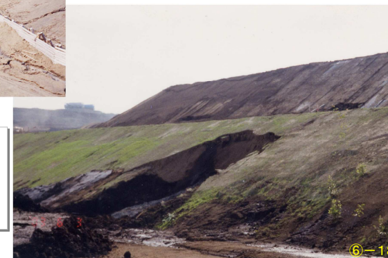
盛土施工後間もないのり面の崩壊の例
