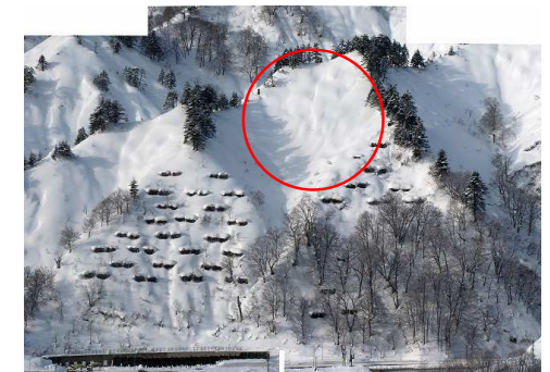
【遠くから】 発生区の全体状況を確認
