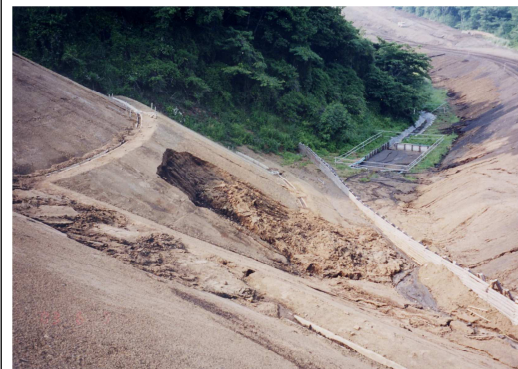
盛土施工後間もないのり面の崩壊の例
