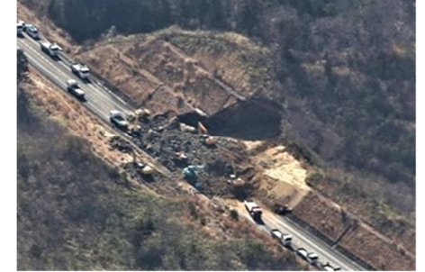
2021年2月福島県沖の地震 常磐道のり面崩壊（国際航業撮影）
