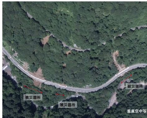
災害発生後の垂直写真(岩手河川国道事務所)
