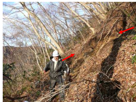
上部斜面に生じた滑落崖(赤矢印間)
