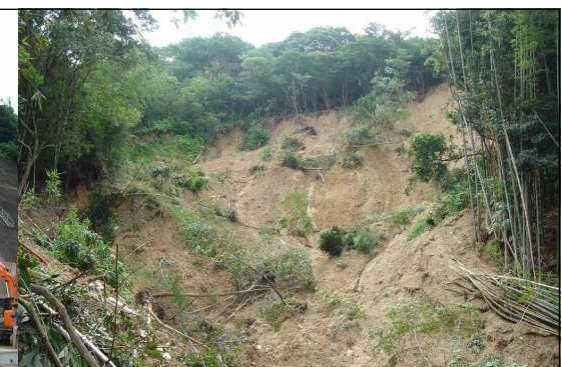
斜面上部の微地形や段差などの状況
