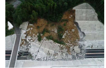
地質・地盤の不確かさの影響が道路開通後に現れた事例 (切土のり面が道路開通の約半年後に崩壊)
