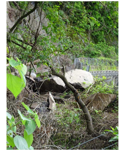
国道445号(熊本県御船町): 落石 長径2mクラスの落石も発生 落石防護施設が損傷
