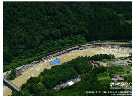
水衝部の国道の被災状況
