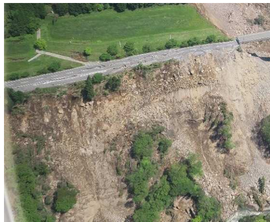
村道橋の木立野線 長陽大橋西側斜面
