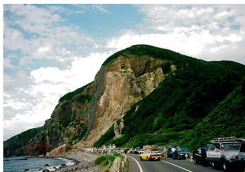
第二白糸トンネルの崩壊（1997年8月）
