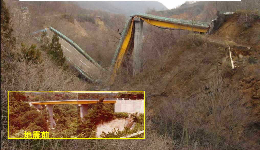
岩手・宮城内陸地震による国道342号祭時(まつるべ)大橋の倒壊状況 (秋田県側の基礎の岩盤が11m移動)
