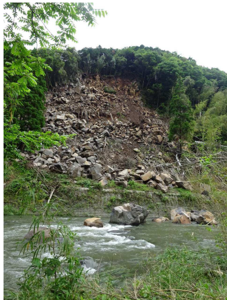
国道445号(熊本県御船町): 岩盤崩壊 長径2m超の落石も多く発生 落石防護網が破損
