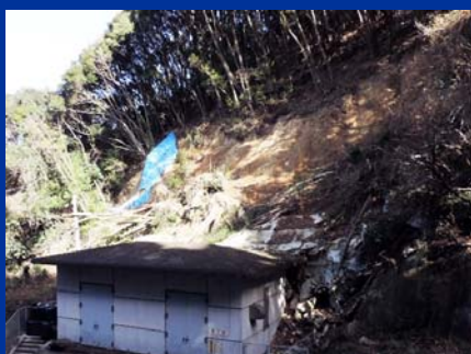
崩壊地の全景
