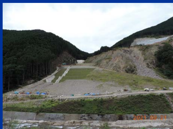
B・Cブロックの動きに対する押え盛土工
