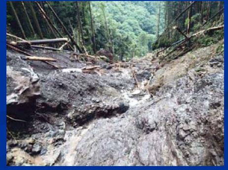
流過部の風化岩の露出状況
