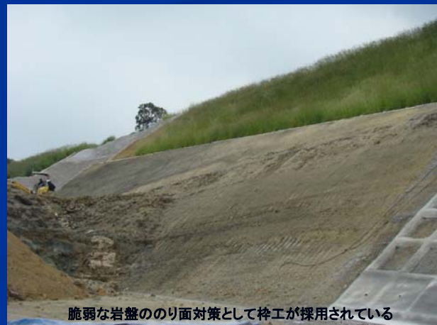
砕内が植生工で対応されているが風化が速い地盤だと要注意
