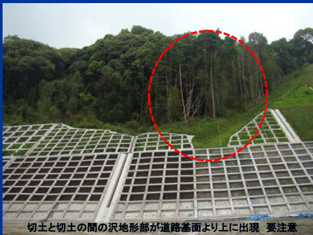
両カットだとどちらかののり面は流れ盤
