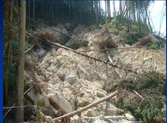
岩芯が玉石状に残留する強風化部
