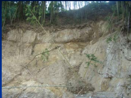
花崗閃緑岩に見られる 水平方向の不連続面 後からの衝上断層？
