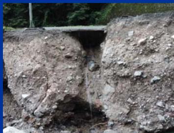
大きく抉られた背面岩盤 * 地下水が流出している。
