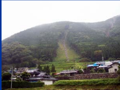
②熊本地震時 平成24年被災箇所の 南阿蘇村立野地区の 長大のり枠工 地震時 も全く健全さを保つ
