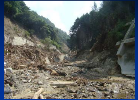
土石流流過域での侵食状況
