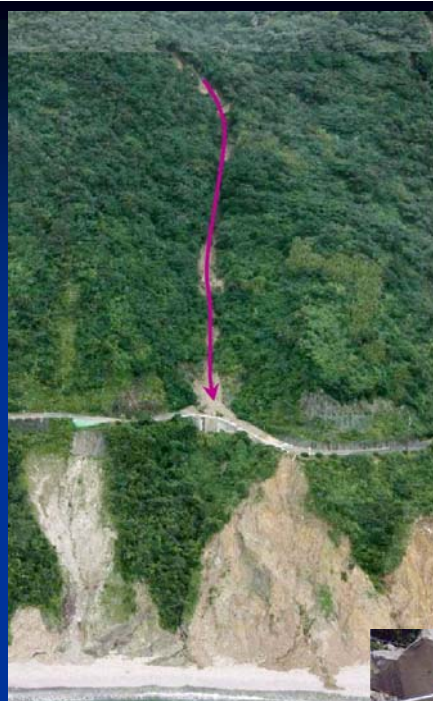
平成22年の崩壊と土石流出
