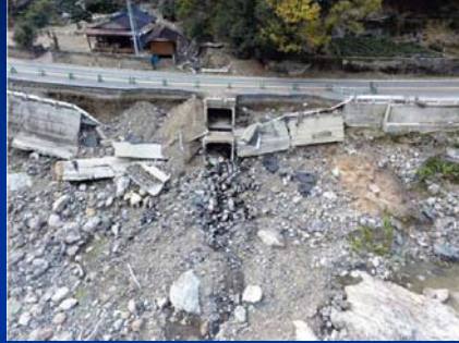
球磨村神瀬のブロック積み擁壁と盛土の崩壊 * 基盤岩はチャート
