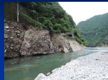
凝灰角礫岩は塊状で開口した割れ目が約10mで観察される
