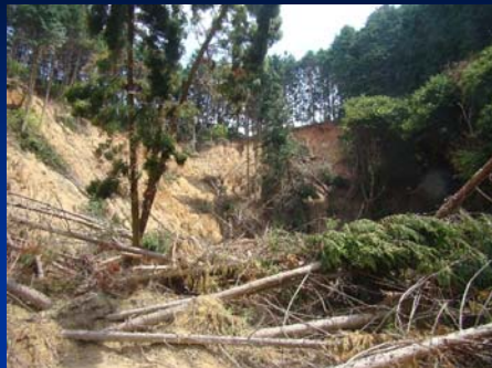
尾根近傍の大規模な崩壊(まさ土)
