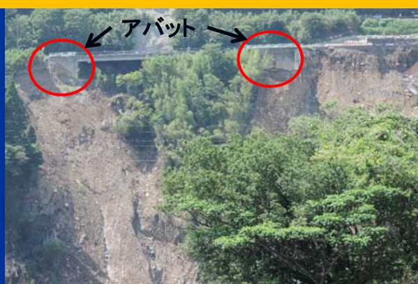
国道57号コンクリート橋台付近の崩壊
