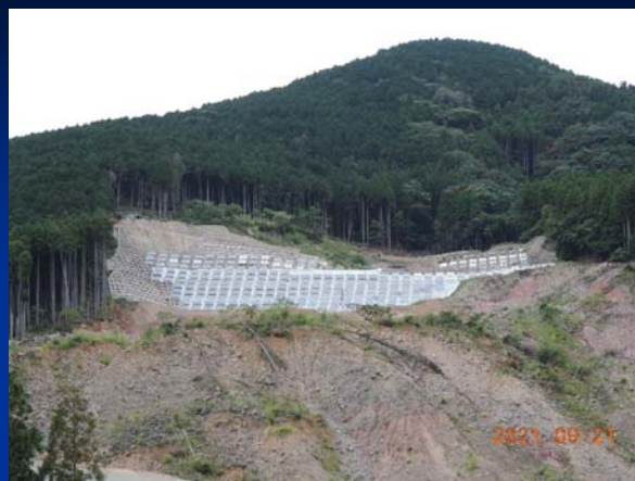
源頭部の対応 アンカー工による抑止工法
