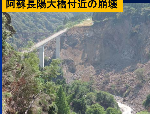
国道57号コンクリート橋台付近の崩壊
