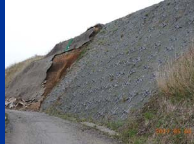
②熊本地震時 平成24年被災箇所の 南阿蘇村立野地区の 長大のり枠工 地震時 も全く健全さを保つ
