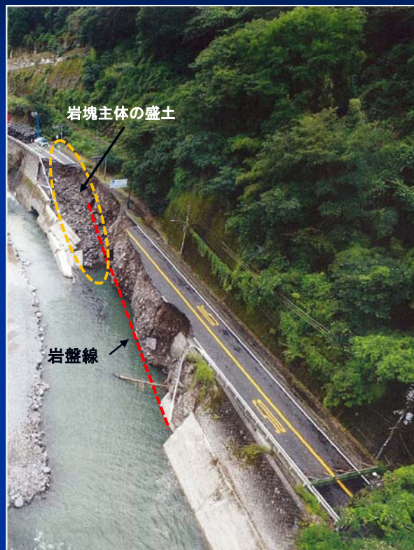
大きく抉られた背面岩盤 * 地下水が流出している。
