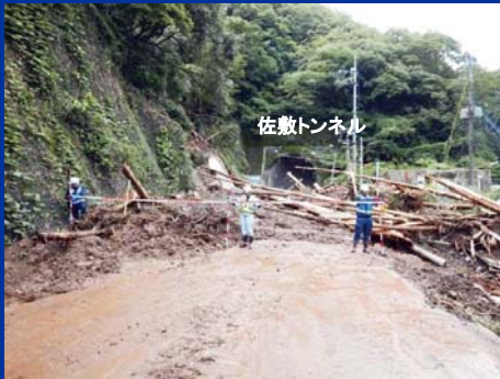
道路への立木・土砂の流出・堆積状況
