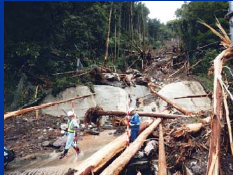
道路への出口付近の状況
