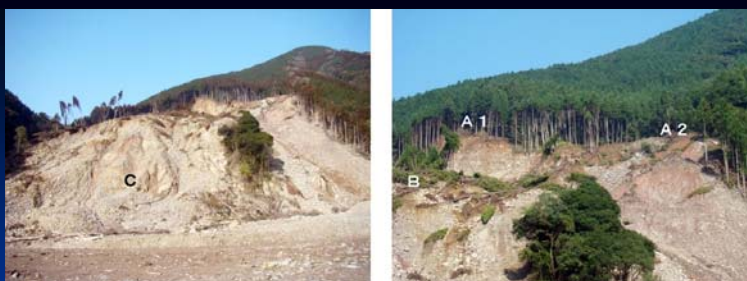
崩壊地の全景
