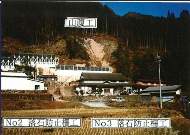
* 落石防護工施工時の写真 崩壊前のCブロックにクサビ型崩壊があったことがうかがえる。
