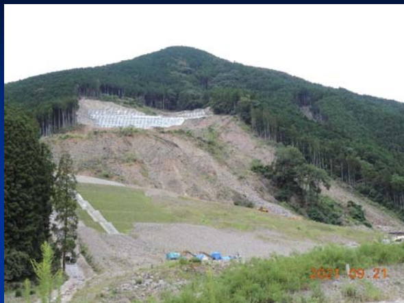
対策工の全景
