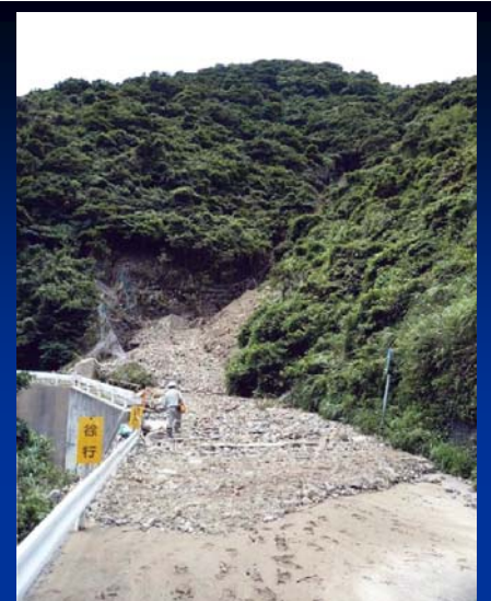
平成22年の崩壊 道路への土石流出状況
