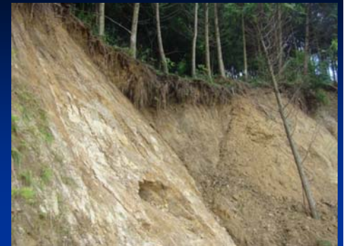
泥質片岩のクサビ崩壊面 に見られる高角の小断層群
