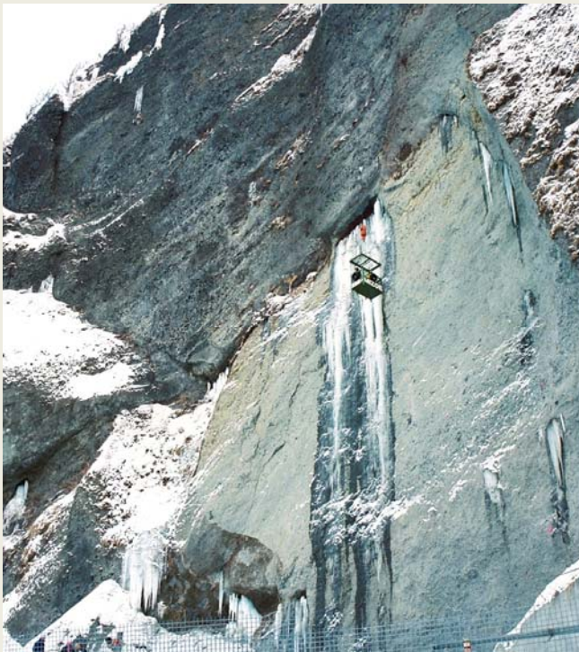
(崩壊後の岩壁をゴンドラで調査中)
