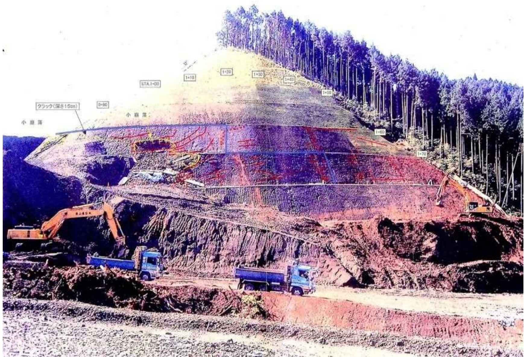
施工時の状況(事務所資料より)
