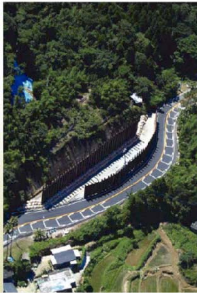
応急復旧の防護柵・迂回路等が完成し、平成18年7月29日13時55分全面通行止めを解除
