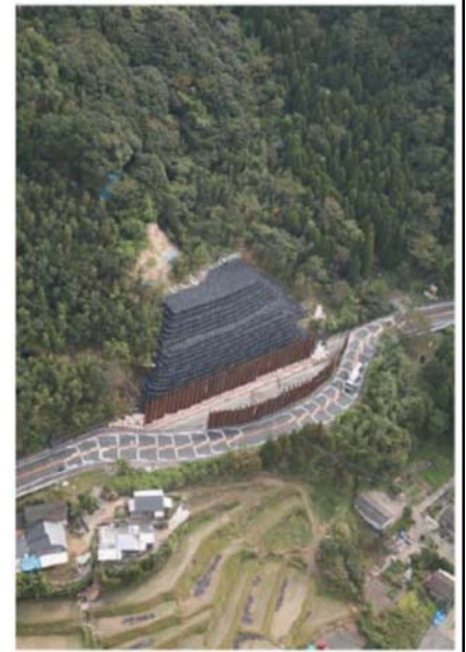
平成18年9月8日 押さえ盛土設置完了。
