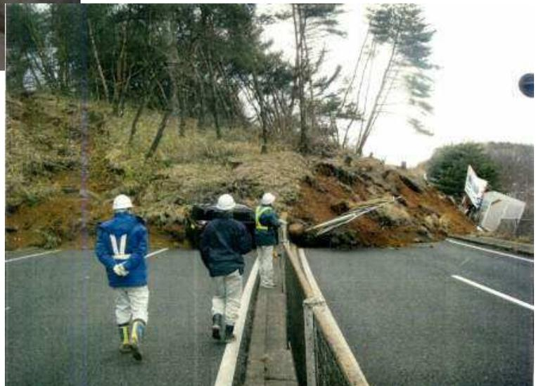
国道を閉塞した崩壊の末端部
