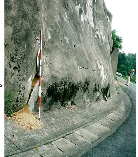
構造物の劣化異常の例(切土のり面)
