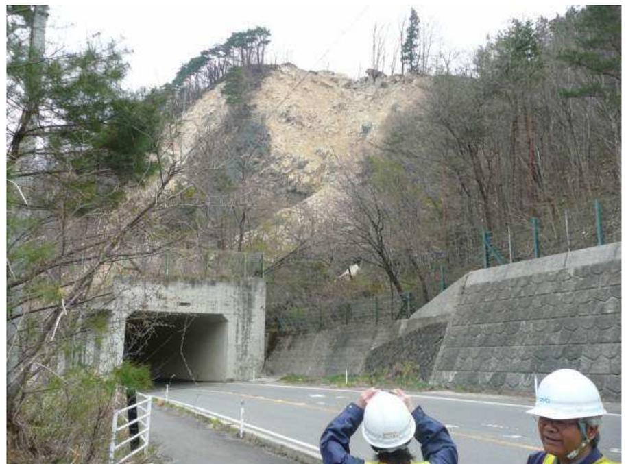
→ (教訓) 地すべり末端が急斜面の箇所は地質も脆弱で地震時に崩壊しやすい。
