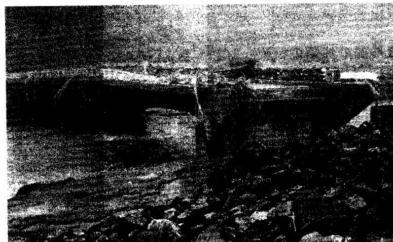
取付道路の流失、陥没、沈下
