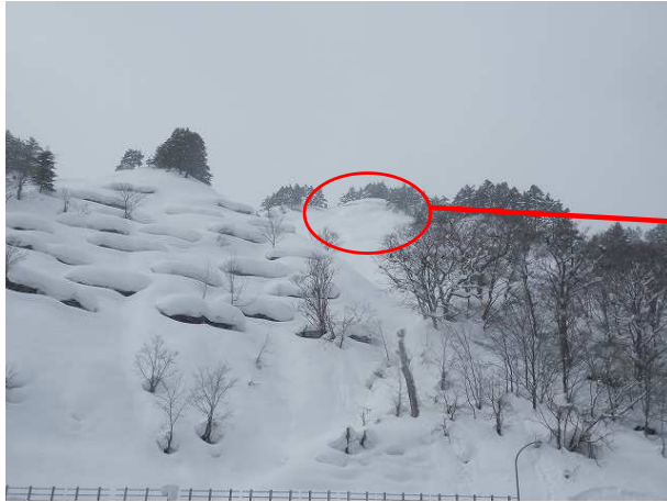
【道路上から】 前兆はほとんど見えない
