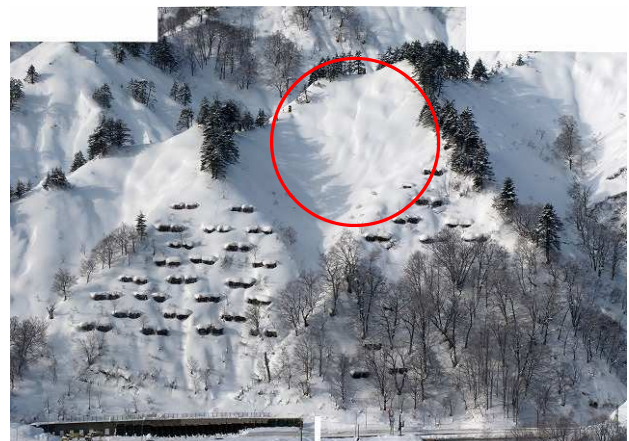
【遠くから】 発生区の全体状況を確認
