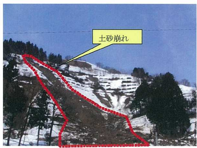
斜面に土砂崩壊の跡などが 見られ、植生が失われている 箇所
