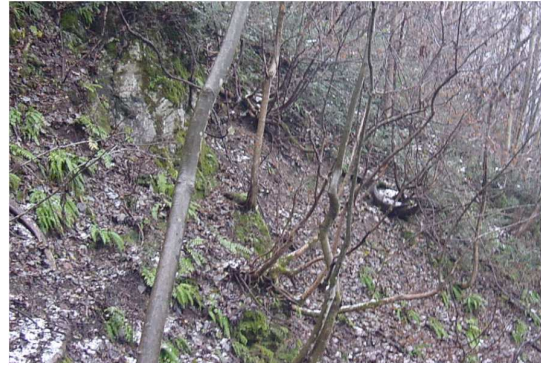
急斜面の表層剥落
