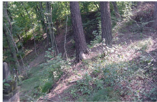
崩壊地形(滑落崖が顕著) ①-33
