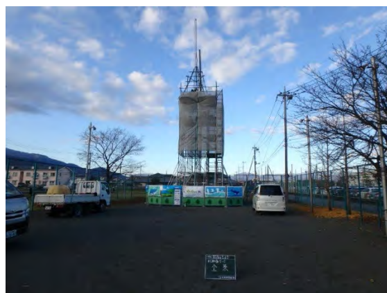
写真6 ボーリング調査全景
