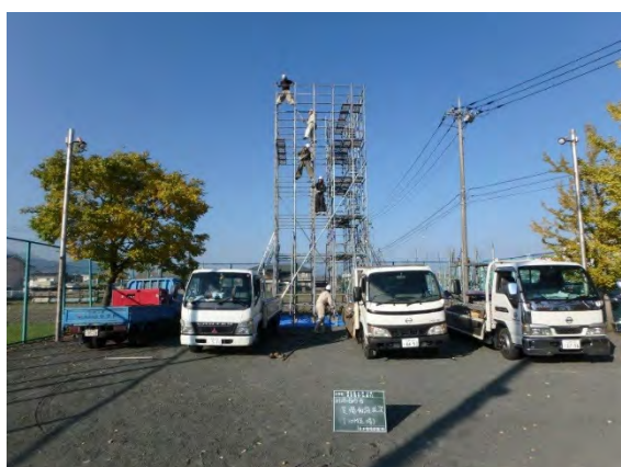
写真3 足場仮設状況（作業員用の階段設置）
