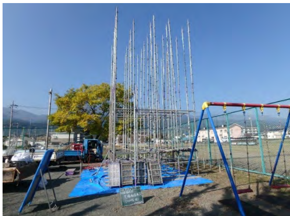
写真1 足場仮設状況
