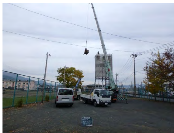
写真5 ラフタークレーンによる機材搬入状況
