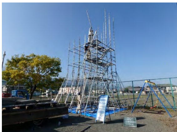
写真2 足場仮設状況（地面にアンカー挿入）
