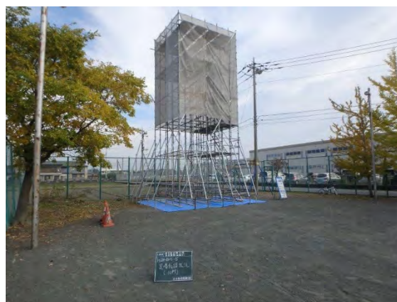
写真4 足場仮設状況（施工後）
