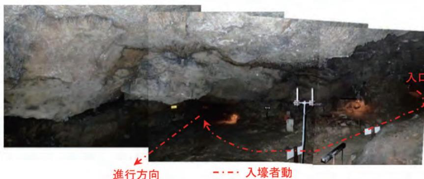
写真2 アブチラガマ（糸数壕）の入口付近（エリア3）の状況。空洞幅が30m以上と本壕中で最も広い。天端岩盤の厚さは6～8mと薄く、後述の検討委員会において安全性の懸念が指摘された。
