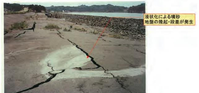
写真-3.1 昭和53年 宮城沖地震被害状況<sup>2)</sup>
