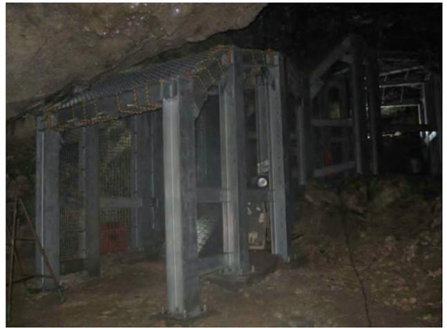
写真 3 安定性に懸念がある箇所（エリア 3）に設置中の入壕者を局所的な落盤から保護する施設（ただし天端の陥没には耐えられない）
