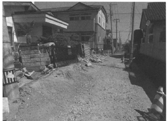
写真5 南光台地区における顕著な隆起域(道路面は復旧の際の掘削によって下げられた)
