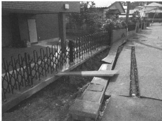
写真3 折立5丁目地すべりにおける頭部～側部引張亀裂
