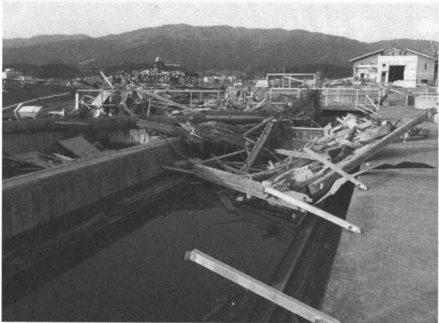
写真1 壊滅的な被害を受けた陸前高田浄化センター（外部）
