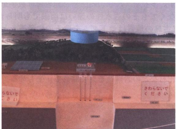
写真3 地下ダムの模式模型（帯水層や配水方法の状況がわかるように模式化している）
