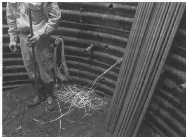
写真6 集水井内の孔曲がり測定作業例
