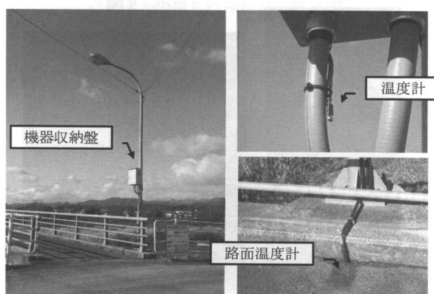
図 5 路面温度 Web 配信システム
