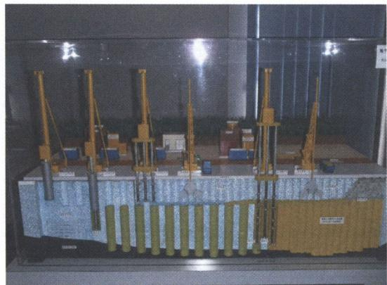
写真4 止水壁の施工方法・手順
