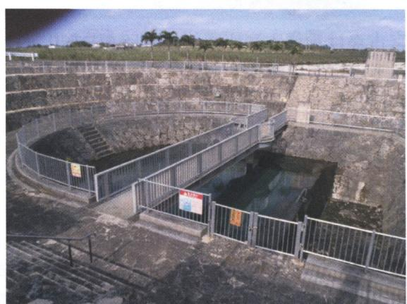
写真6 福里地下ダムの止水壁
