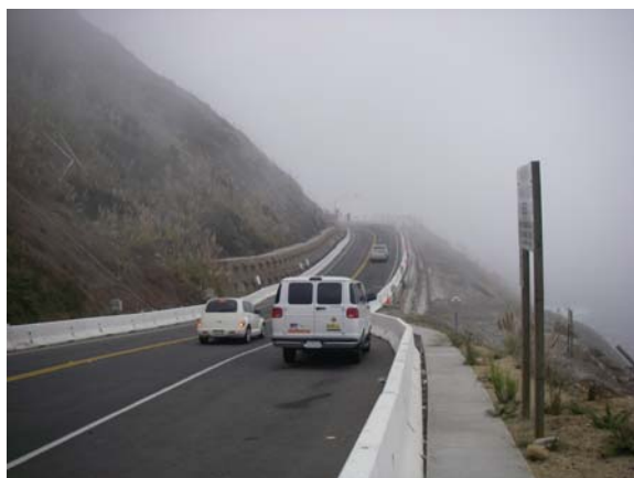
写真-32 Devil's Slide 地区地すべり対策箇所と主要道路 1 号線（北側より望む） 駐車中の車が、私たち送迎用の Caltrans 所有車
