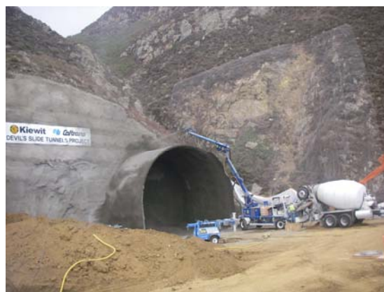
写真-38 北線南坑口での吹付けコンクリート施工
