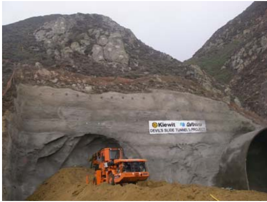
写真-39 南線南坑口 坑口上方の白っぽい点がロックボルト施工箇所
