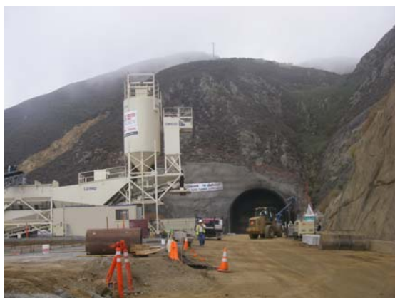
写真-37 南坑口部全景 坑口上方には花崗岩類の露岩部が認められる
