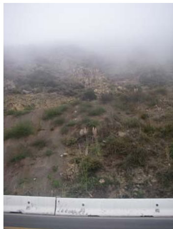
写真-35 道路上部部の斜面状況 不安定な浮き石が確認される
