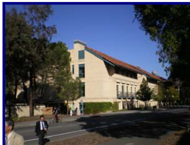
写真-30 実験室が入る建物
