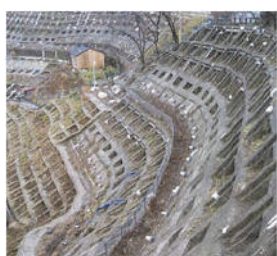
特殊土木工事
