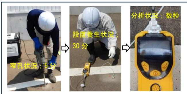
図-3 PID ガスモニター作業状況
