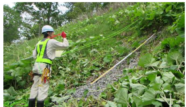
写真-3従来の斜面点検状況
