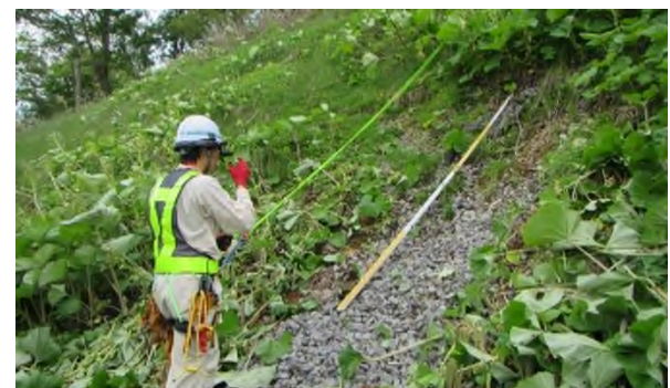
写真-4 スマートグラスによる斜面点検状況
