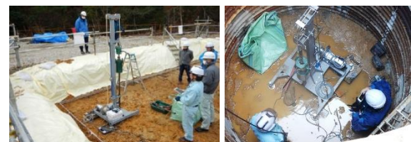
写真-5 鉄塔基礎床付け検査状況
