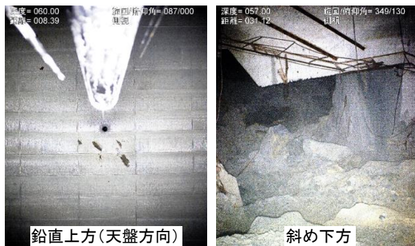
写真-2 空洞内部の写真撮影事例
