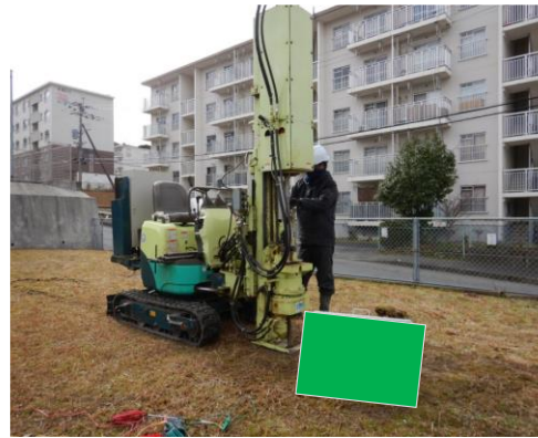
写真-1 オートマチックラムサウンディング試験状況
