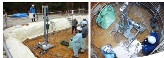
写真-5 鉄塔基礎床付け検査状況
