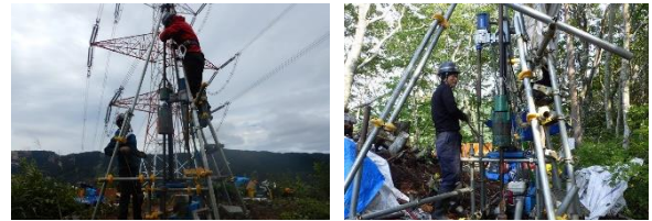
写真-1 コアカッター搭載型ポータブル貫入試験機全景
