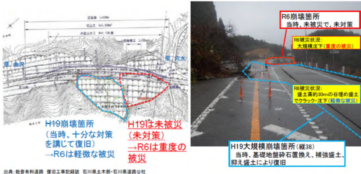
図-2 道路土工(能越道)の被災調査結果の概要 4)
