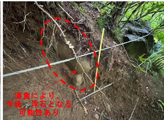
写真-6 浸食による露岩状況
