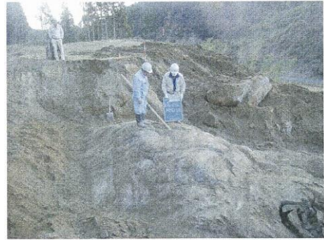
写真-1. 岩盤露出状況
