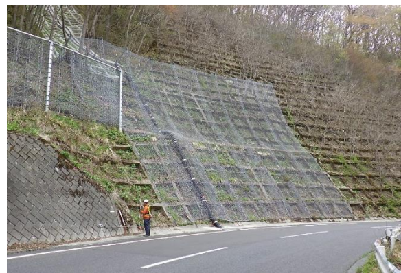
写真-2. 施工後のポケット式落石防護網工
