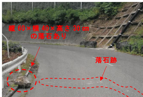
写真-1 落石時の路面状況
