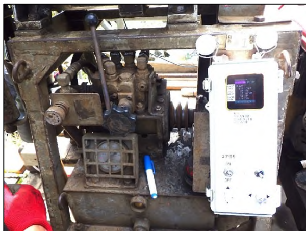
図-4 操作ユニットの現場設置状況
