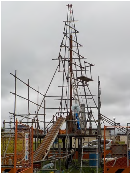
写真-2 ケーシング立ち上げ状況
