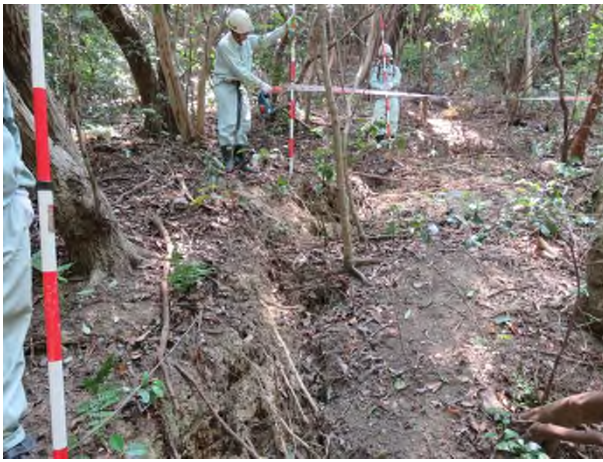
写真 1 ①ブロック中央滑落崖状況
