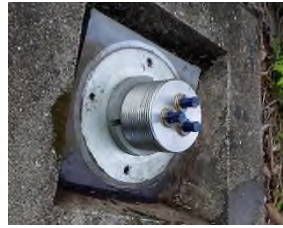
写真-3 露出状況写真(B-2)
