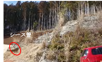
写真-1 のり面周辺状況写真
