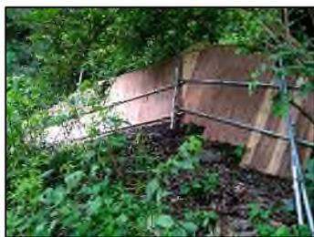
写真-5 簡易落石防護柵
