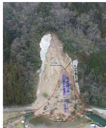
写真-15 岩盤クリープ地盤にモルタル吹付後に崩壊した現場
