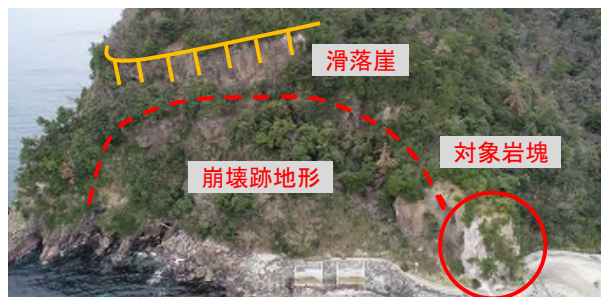
写真-3 対象岩塊背後の崩壊跡地形
