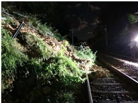
図-1 鉄道切土斜面の土砂崩壊
