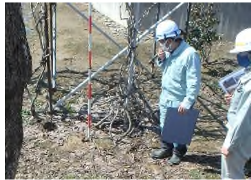
写真-2 漏水箇所③噴砂跡
