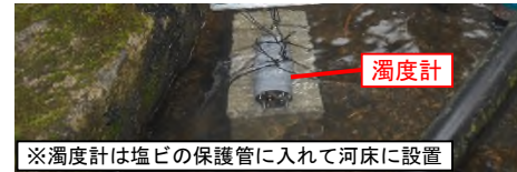
写真-1 濁度計の設置例 (沢)
