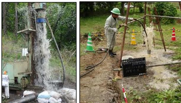
写真-1 さく井工事・井戸改修中の懸濁水発生状況
